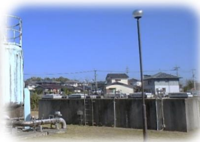
高田浄水場内（着水井）
