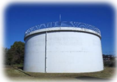
高田浄水場内（PC配水池）
