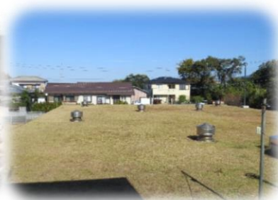
腹赤浄水場内 (地下RC配水池)
