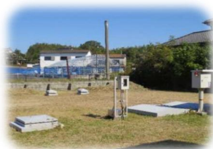
梅田浄水場内（地下RC配水池）
