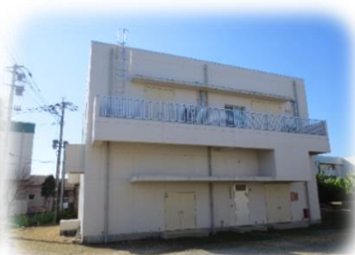
腹赤浄水場内 (管理棟)
